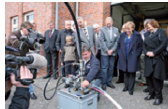
Vorführung Glasfasereinblasen mit der Firma Vetter. Burkhard Köpke bläst mit dem „Minijet“ die Faser in Rohre mit Durchmesser von 4 bis 16 Zentimeter
