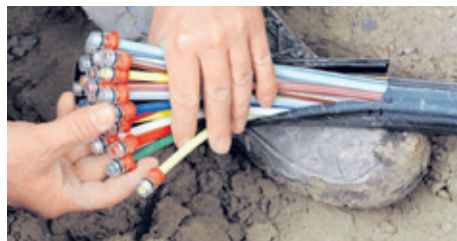
Wird ab jetzt in elf Gemeinden auf Rügen bis zum Keller verlegt – das Glasfaserkabel für das Turbointernet. FOTO: PETER KNEFFEL
